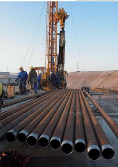
Bohranlage RB 50 beim Einbau der Gefrierrohre
