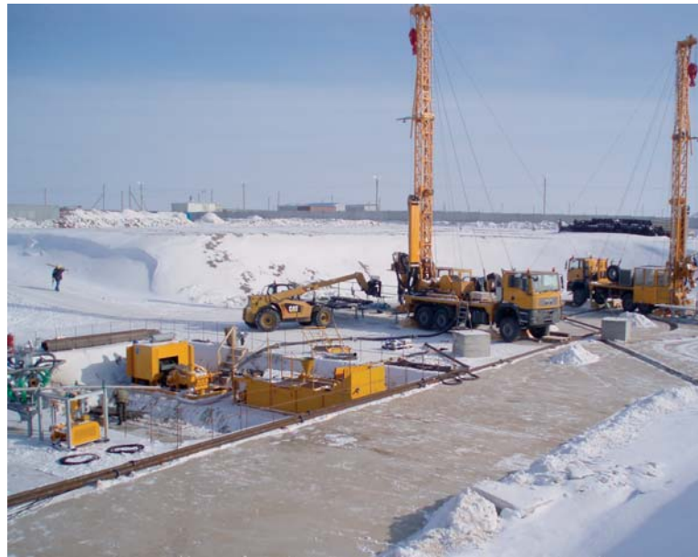
Montage der Bohranlagen RB 50 zum Erstellen der Gefrierbohrlöcher im Februar 2009
