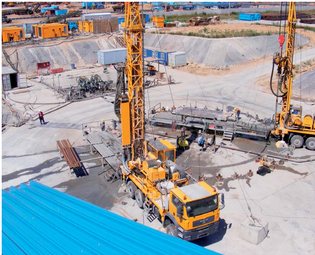
S. 18: Bohranlagen RB 50 beim Erstellen der Gefrierbohrlöcher mit Spülungssystem
