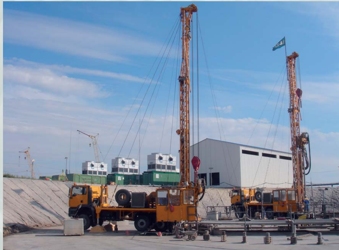
RB 50 Bohranlagen mit Gefriermaschinen, Pumpenhaus und Thyssenfahne im russischen Himmel
