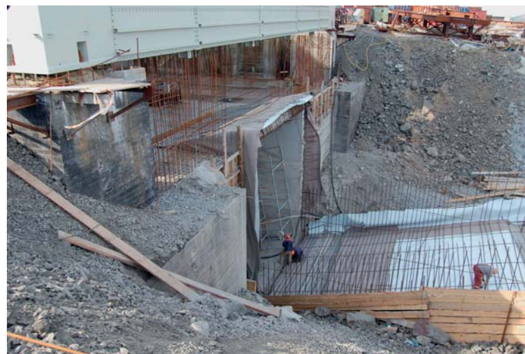
Unten: Anschluss des wasserdichten Wetterkanals, dieses Konzept wurde zum ersten Mal in Norilsk angewendet
