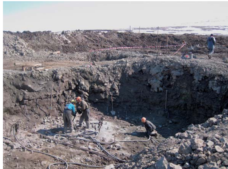
Oben: Jeder Schacht fängt einmal klein an, bereits 4 Monate nach Auftragsvergabe
