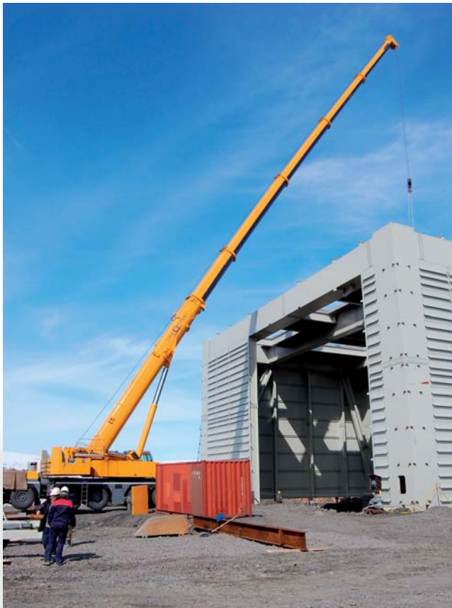
Aufbau der Schachthalle, hier entsteht das höchste Fördergerüst in Norilsk
