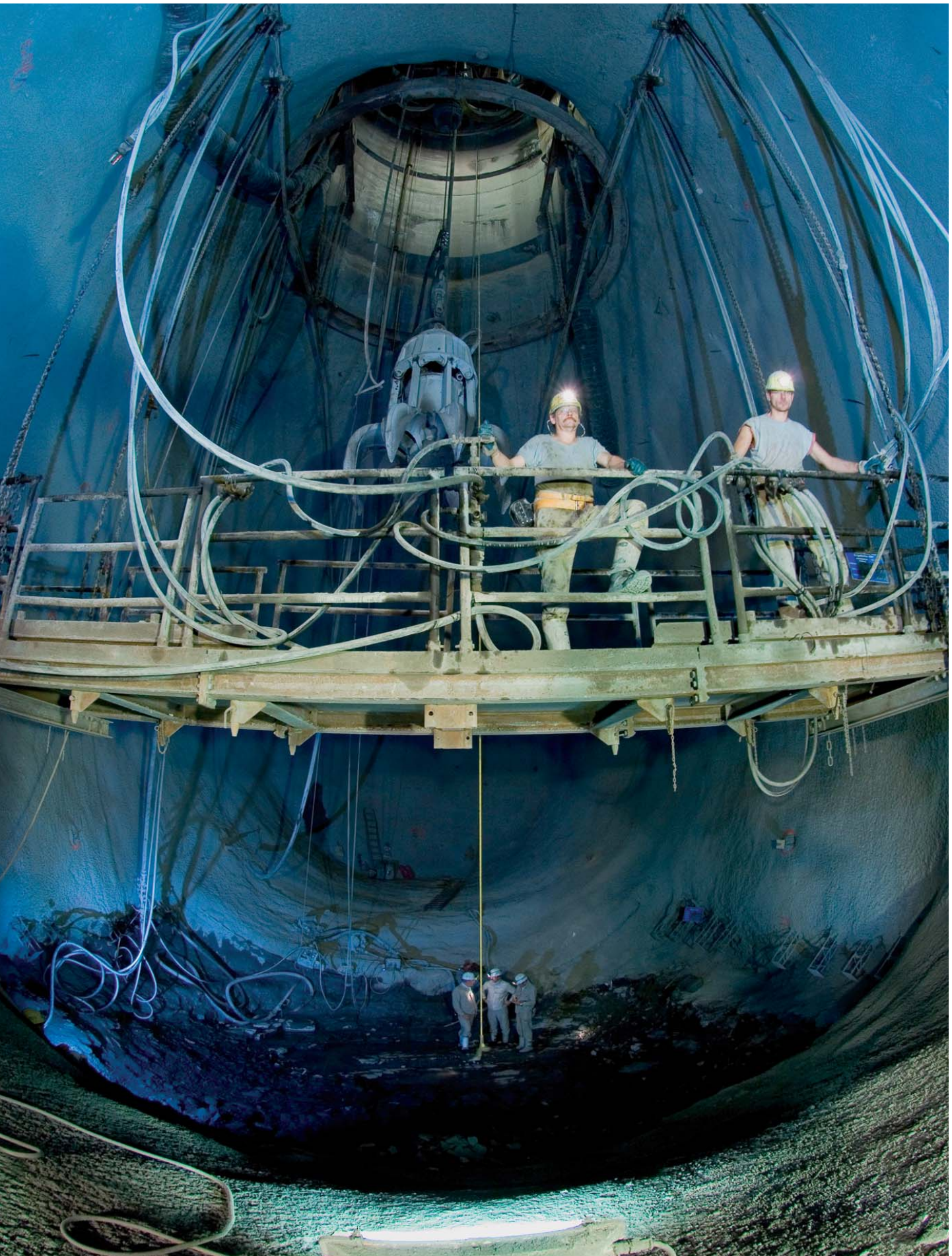
Füllort 7. Sohle, Stahlfaserspritzbetonschale mit Systemankering
