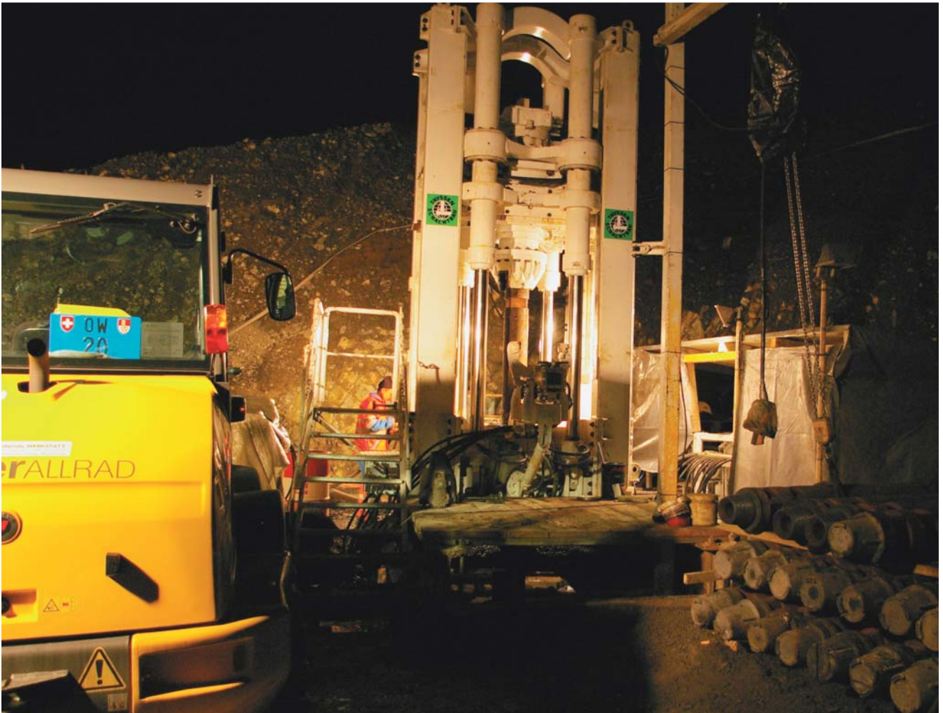
S. 32: Rotzloch – eine Baustelle mit herrlicher Aussicht
