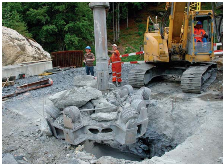
Oben: Der Stollen erreicht die Pilotbohrung, der Meißel kann nun gegen den Bohrkopf getauscht werden
