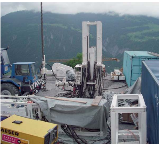
Unten: Installation der HG 160-2 Bohranlage
