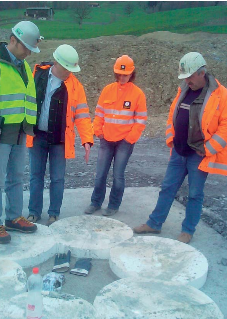
Oben: Bohrplatz Wasserschloss nördlich Seewis-Dorf, Bohrfundament und Bohrfahlpositionen für Gebirgsvergütung
