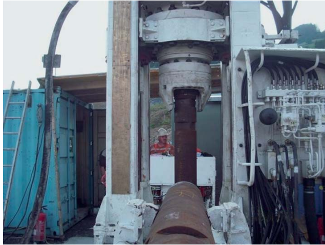
Rechts: Durchschlag der Pilotbohrung, Erweiterungsmeißel montiert
